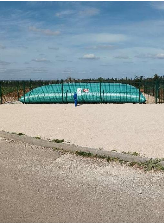
Mise en conformité de la couverture incendie installation d'une bâche souple hors sol de 120m3
