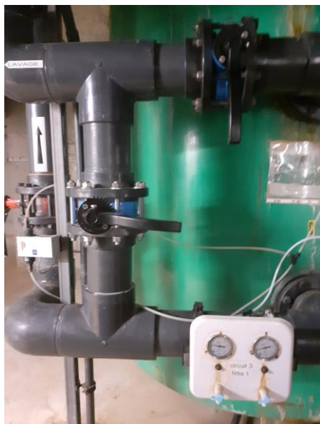
Remplacement des vannes Nemausa
