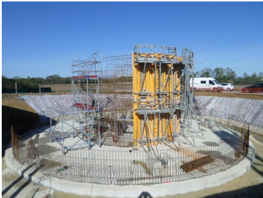
Tranche 2 de la STEU de La Gardonnenque – réalisation du bassin d'aération
