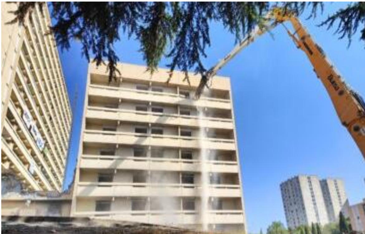
Démolition du Pollux sur Pissevin – Un Toit pour Tous
