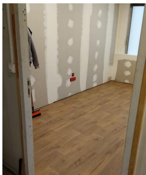
Ancienne salle CIUVP après travaux
