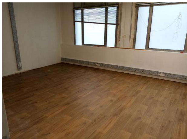
Ancienne salle CIUVP avant travaux
