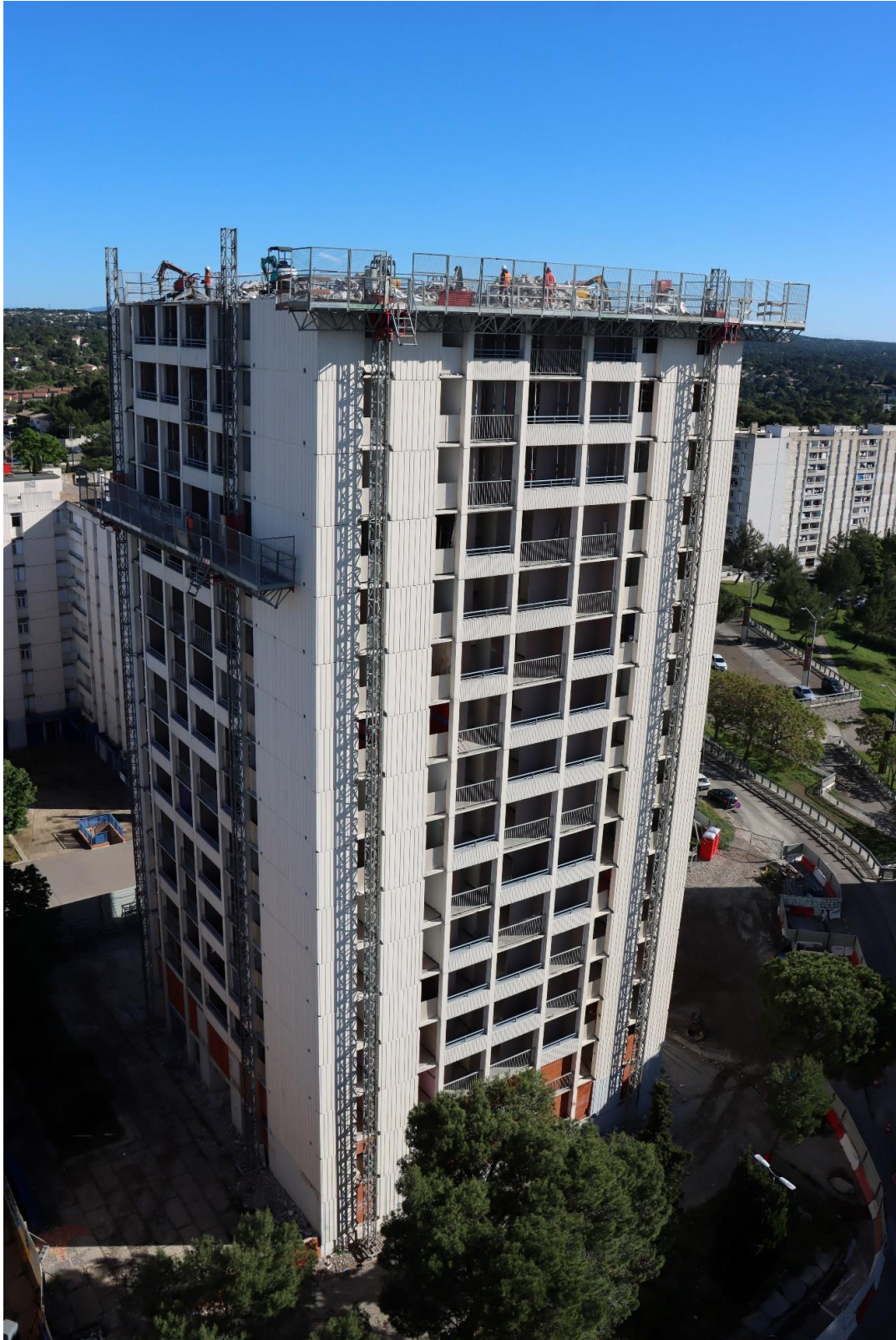
Démolition d'Avogadro sur Valdegour - Habitat du Gard
