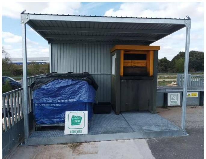
Mise en conformité des cuves huiles minérales (après (pose sous abri)
