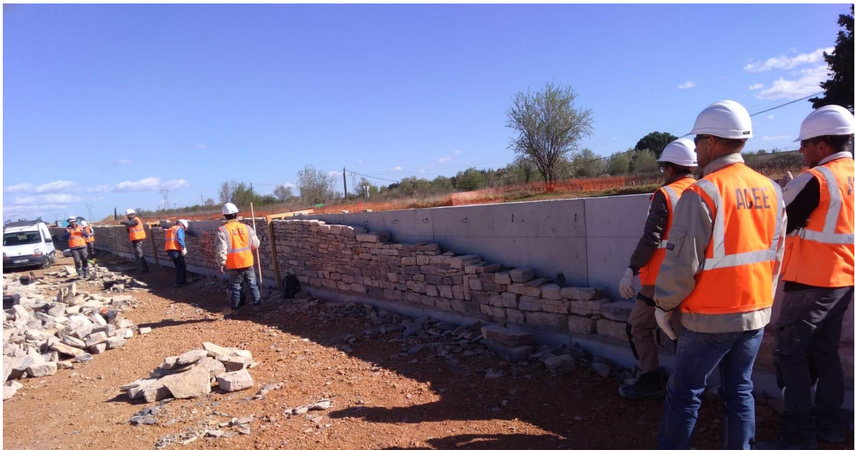
Chantier d'insertion – Création d'un mur en pierre sèche
