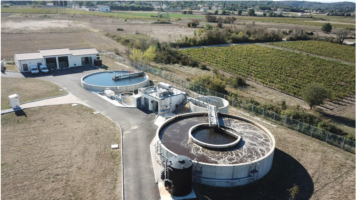
Tranche 1 de la STEU de La Gardonnenque – en service
