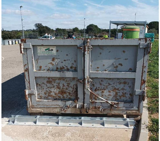
Mise en place de butées à l'arrière des bennes
