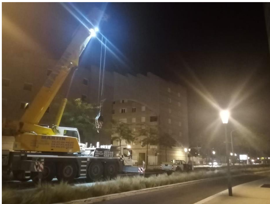
Livraison de la pompe à chaleur
