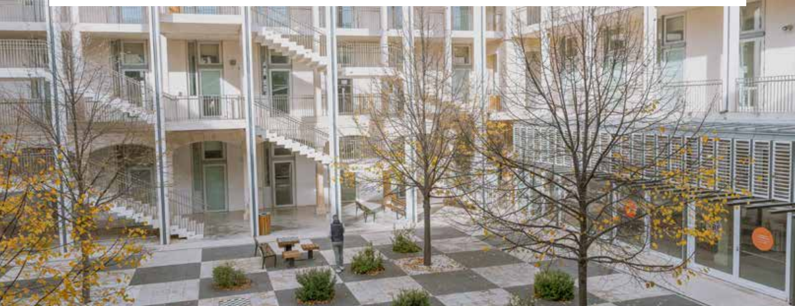
Vue de la cour intérieure de l'université Hoche de Nîmes
