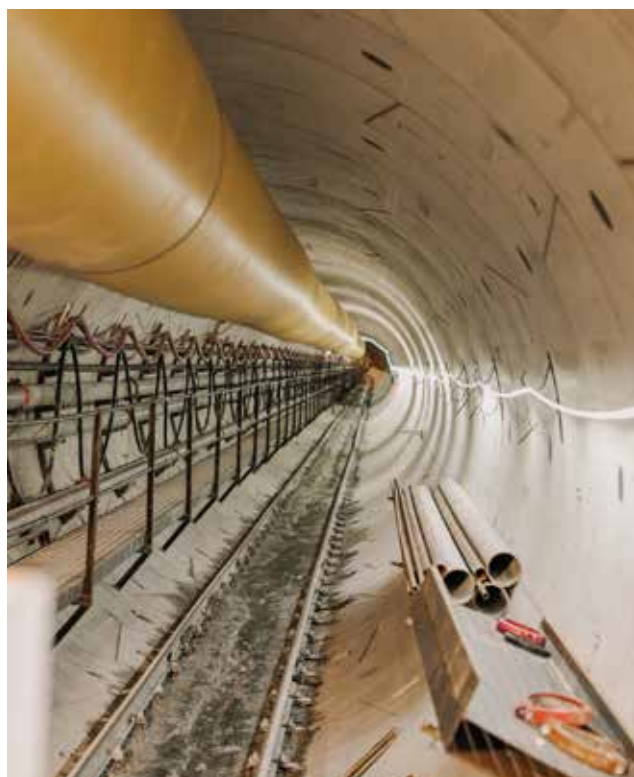
Vue intérieure du tunnelier
