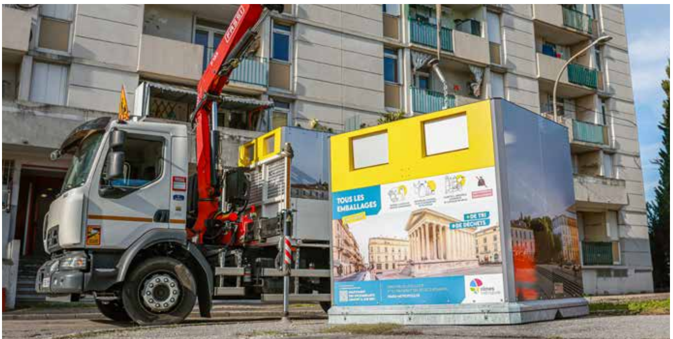
Installation des colonnes d'apport volontaire dédiées aux emballages sur le quartier Chemin-Bas d'Avignon à Nîmes
