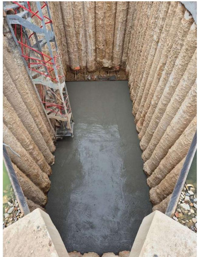
Photo du 19/09/2024 : Mise en place du béton en fond de puits
