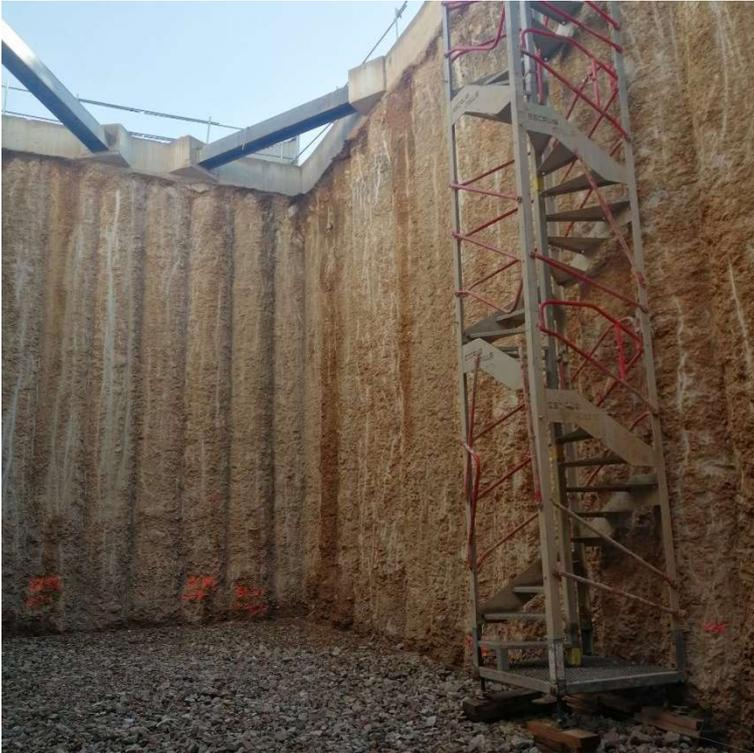
Photo du 08/09/2024 : Fin du terrassement , réglage du fond de fouille
