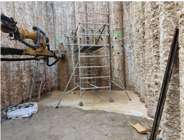
Photo du 15/11/2024 : Carottage pour préparation de la voûte parapluie (Renforcement de terrain pour la sortie du tunnelier)
