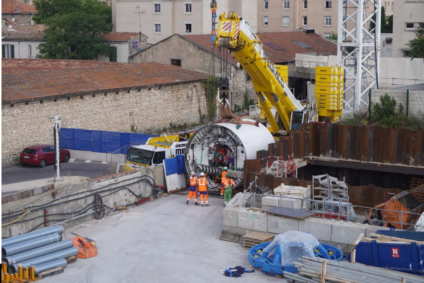
Photo du 27/06/2024 Préparation pour levage d'un élément du tunnelier
