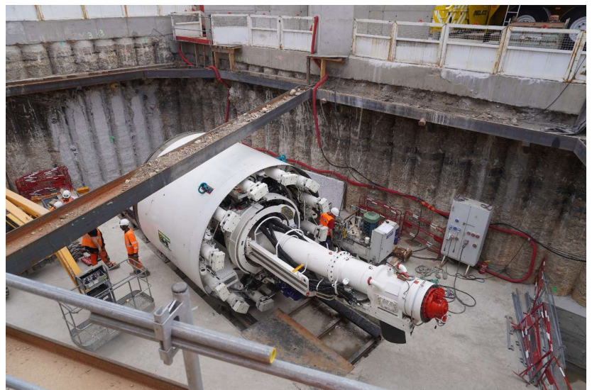
Photo du 26/06/2024 Descente d'un élément du tunnelier de nuit
